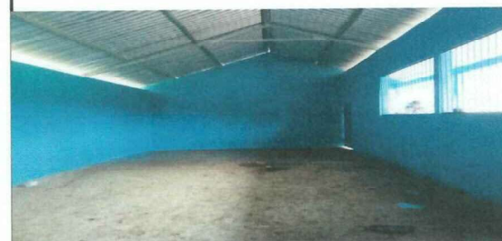
Foto 6: VISTA INTERIOR, COLOCACION DE PUERTA Y BALCONES
