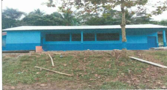
Foto 2: CUBIERTA DE LAMINAS TROQUELADA TERMINADO
