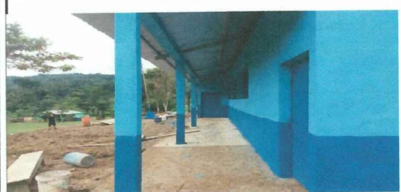
Foto 5: TRABAJOS FINALIZADO EN EL CORREDOR DE LA ESCUELA
