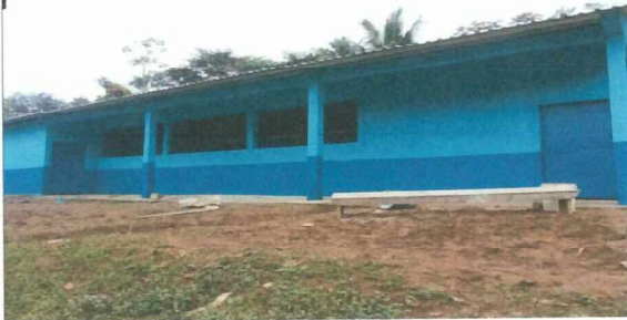
Foto1: . PINTURA FINALIZA INTERIOR Y EXTERIOR
