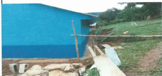
Foto 2: CUBIERTA DE LAMINAS TROQUELADA TERMINADO
